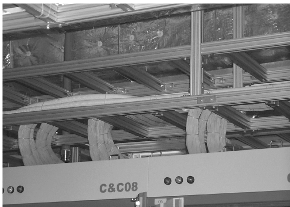
图 3.25 中继电缆在走线架上走线方法
