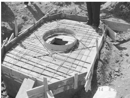
图 2.2 正在建设中的人孔
