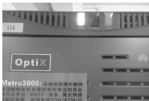
图 5.47 Opti×Metro 3000 设备正常运行时, 机柜指示灯显示
