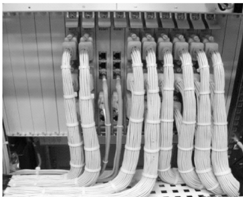
图 3.21 2M 同轴电缆走线
