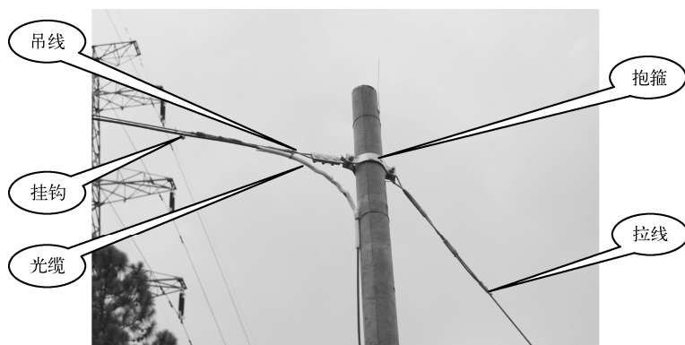
图 2.9 吊线和拉线示意图
