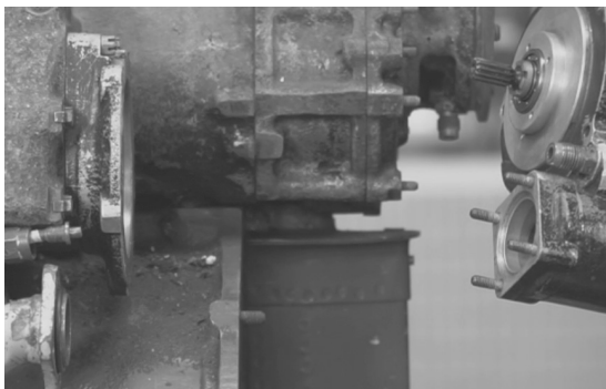
图 10.71 安装中介油泵
